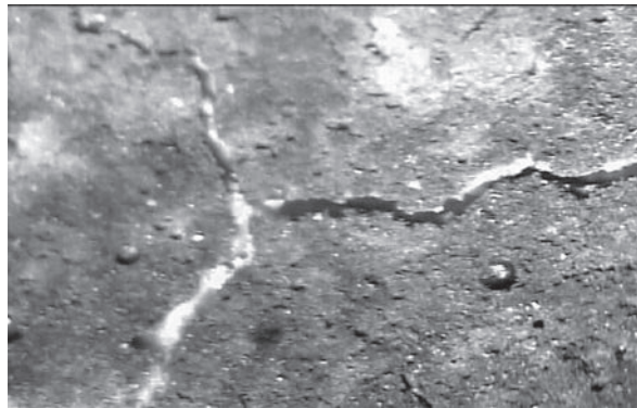
Figura 9. Grietas en dirección axial de los prototipos después del ensayo de llama Fuente: elaboración propia
